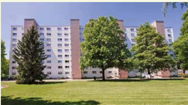
Eine nach der Sanierungsberatung durch die Münchner Gesellschaft für Stadterneuerung (MGS) abgeschlossene Sanierung
